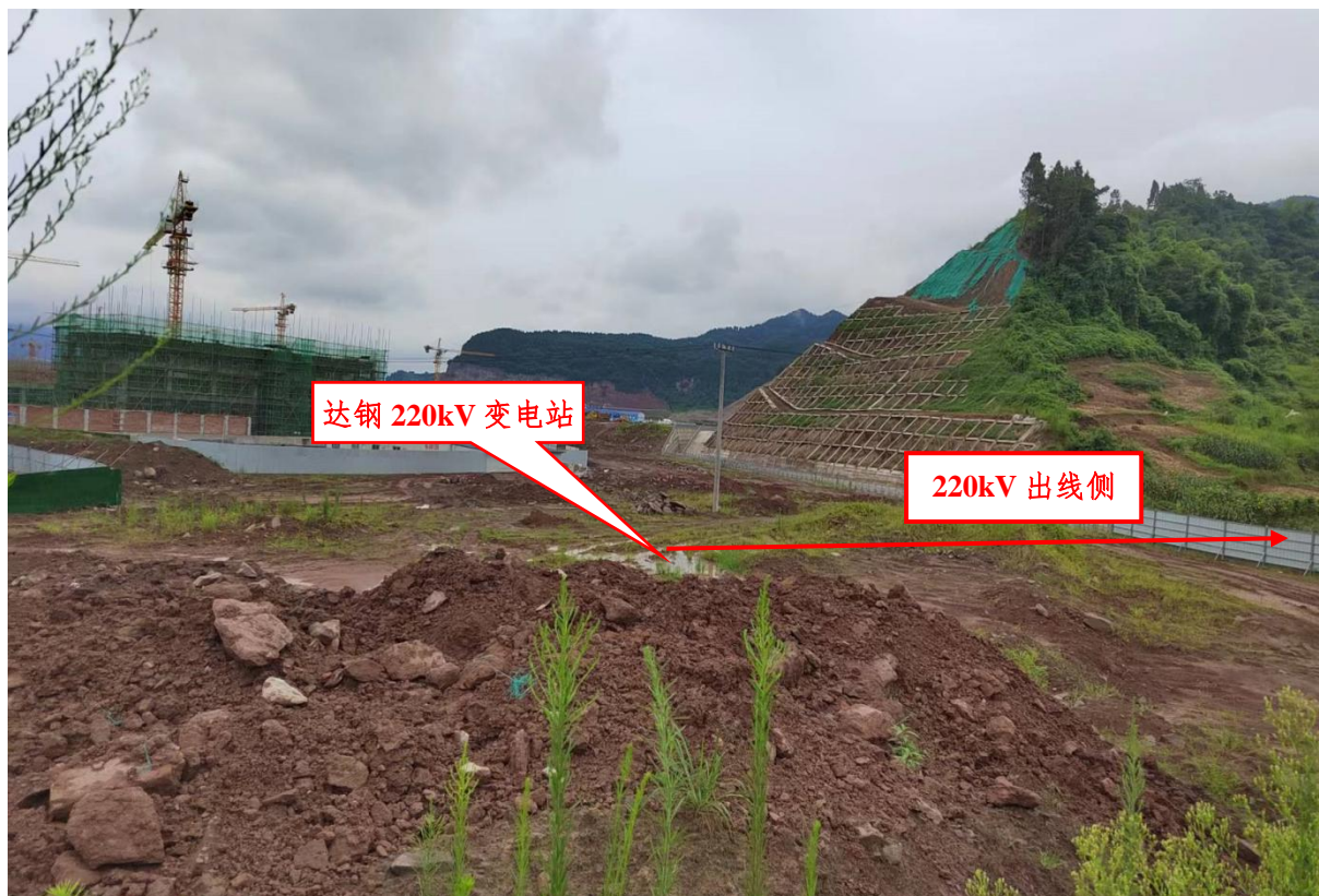
达钢 220kV 变电站
